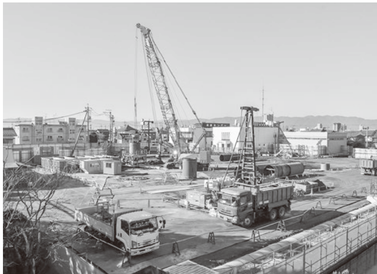
災害拠点施設として市民の命を守る新庁舎の建設
